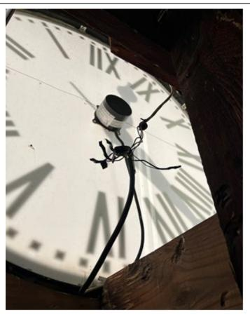
PHOTO 3 RIGHT: CLOCK MOTOR SPLICE WITHOUT A JUNCTION BOX
